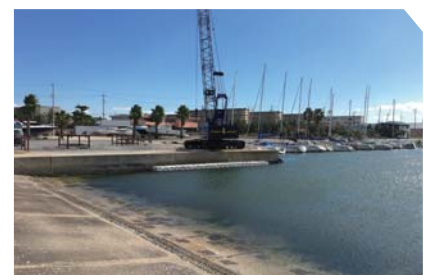
スロープ&大型クレーン完備
