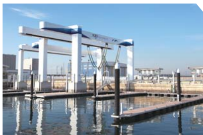
60t大型クレーン
