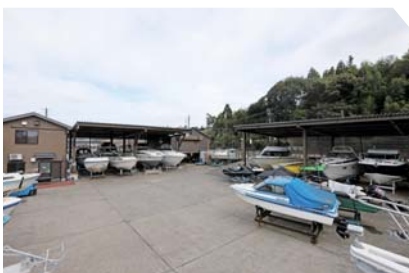
陸上保管ヤード(屋根付き艇庫有り)
