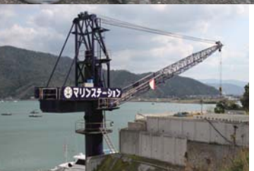
大型クレーン(15t)も完備している。
