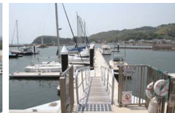
栈橋は綺麗で幅もしっかり確保してある。
