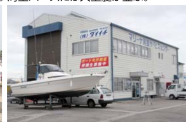
50ft対応の屋内サービス工場を完備。
