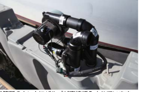
4箇所のタンクにバルブが直接挿入されています。
