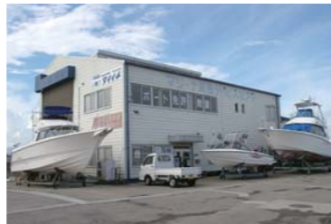
50ft対応の屋内サービス工場。
